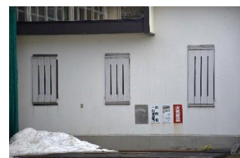
渡り廊下前の窓板
