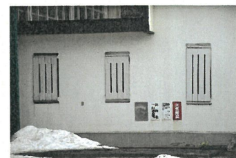
渡り廊下前の窓板
